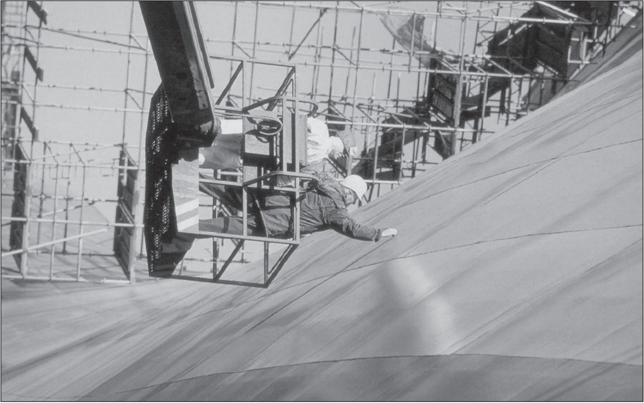
Gerüstbau an der Schiffsaußenwand
